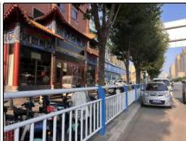
项目现状 (2、3号楼)
