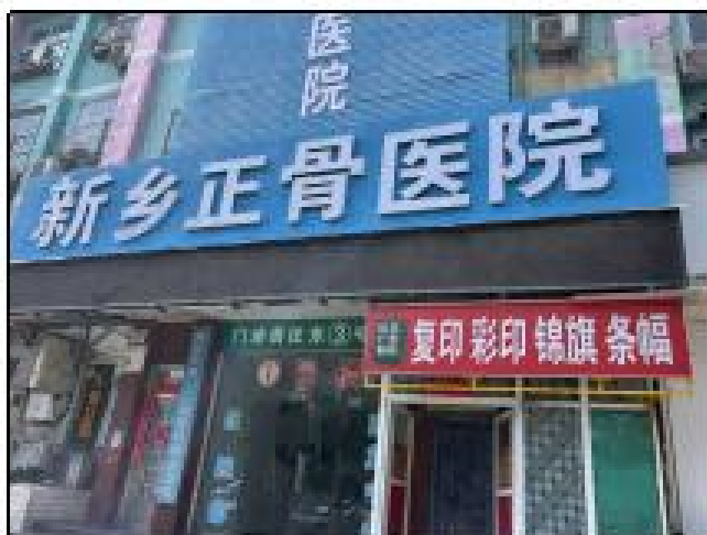
项目现状 (1号楼)
